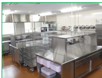
本格的な厨房を設置
