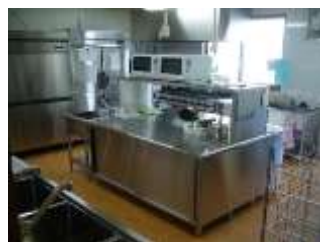
本格的な厨房を設置
